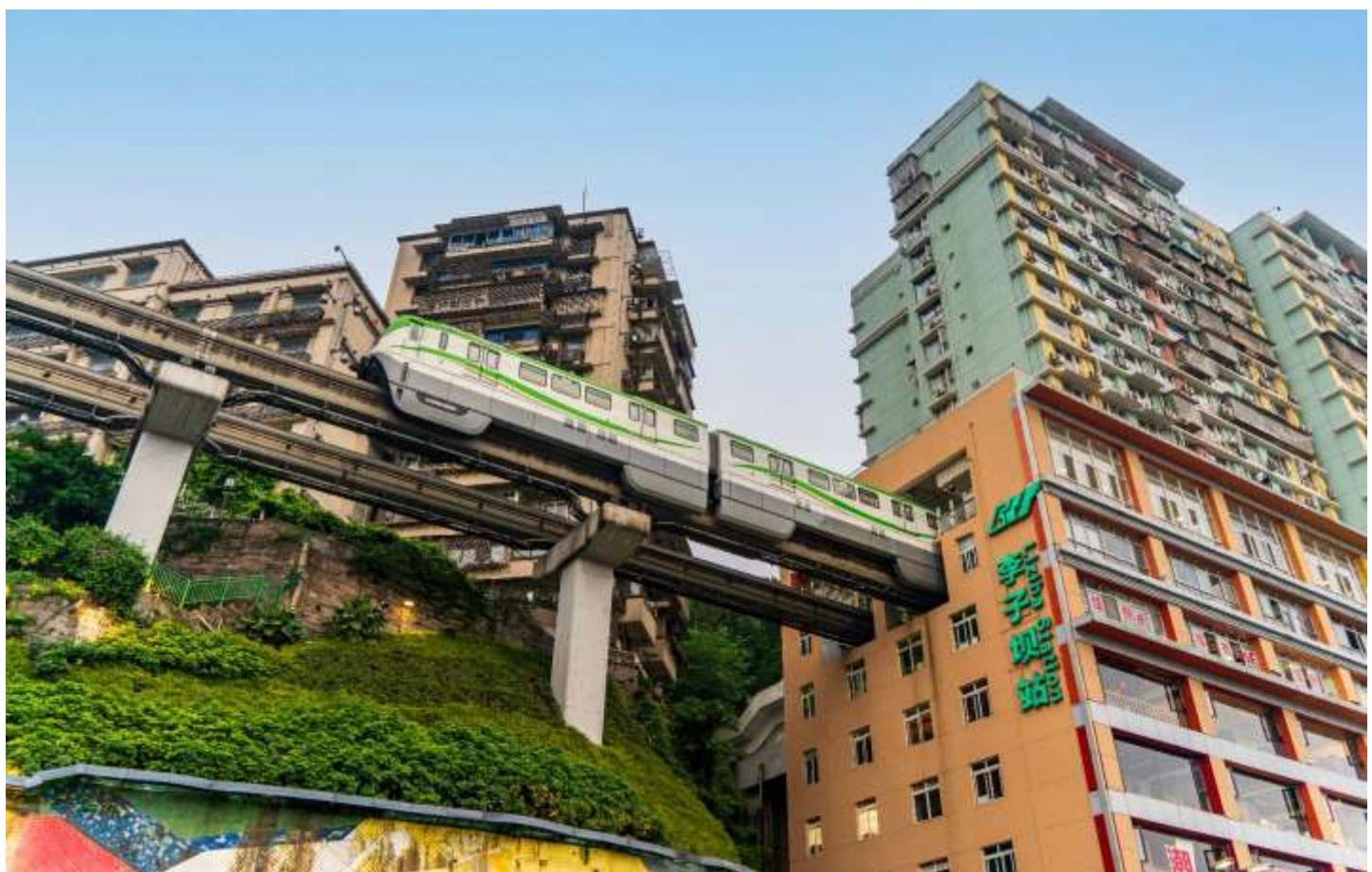
นำทุกท่าน สัมผัสประสบการณ์ นั่งรถไฟฟ้าลูกฟูก เป็นรถไฟฟ้าสาย 2 ของมหานครฉงชิ่ง ที่กำลัง วิ่งผ่านสถานีหลิจือป้า (Liziba Station) ทะลุตึก 19 ชั้น ซึ่งเป็นอาคารที่พักอาศัยของประชาชน รถไฟฟ้าสายนี้ถูกสร้างขึ้นโดยไม่ต้องรื้อถอนตึกดังกล่าว โดยสถานีหลิจือป้าใช้พื้นที่เพียงชั้น 6-8 ของตัวอาคารเท่านั้น แต่ประชาชนที่อาศัยอยู่ไม่ต้องกังวลเรื่องของเสียงรบกวน เนื่องจากผ่านการออกแบบให้สามารถลดเสียงการทำงานด้วยอุปกรณ์ชนิดพิเศษ ที่ทำให้เสียงของรถไฟฟ้าสายนี้ดังเท่าเครื่องล้างจาน (ประมาณ 75.8 เดซิเบล)
